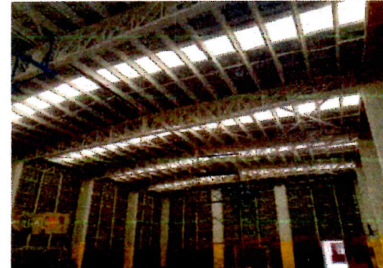
Cambio del luminaria y arreglo techo gimnasio
